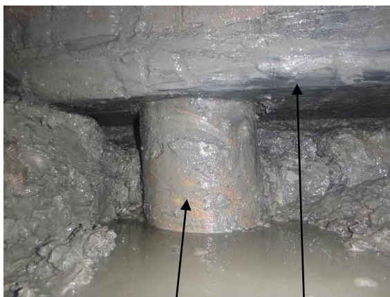
Paal 1.2 langshout voorgevel
