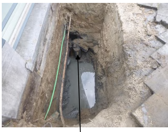
Situatie paal 2.5 naast de gevel
