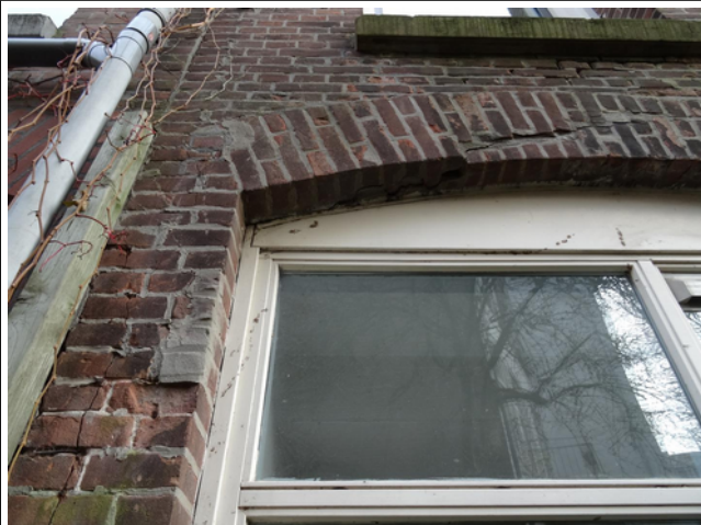
Foto 5: Close-up foto scheuren metselwerk boven raam- en deurkozijn keuken.
