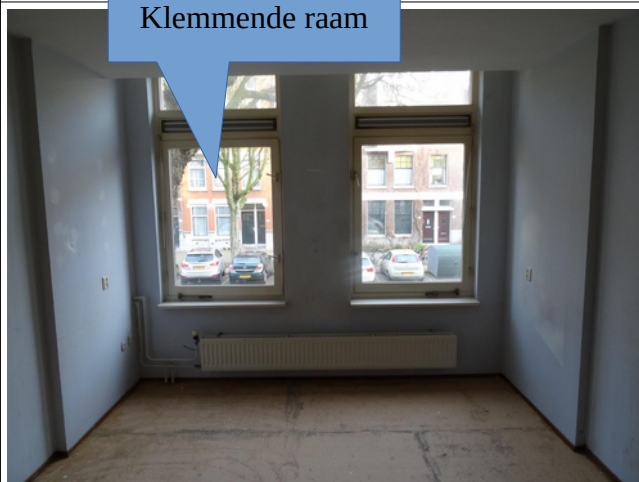
Foto 12: Raamkozijnen voorgevel 1° verd - hout
