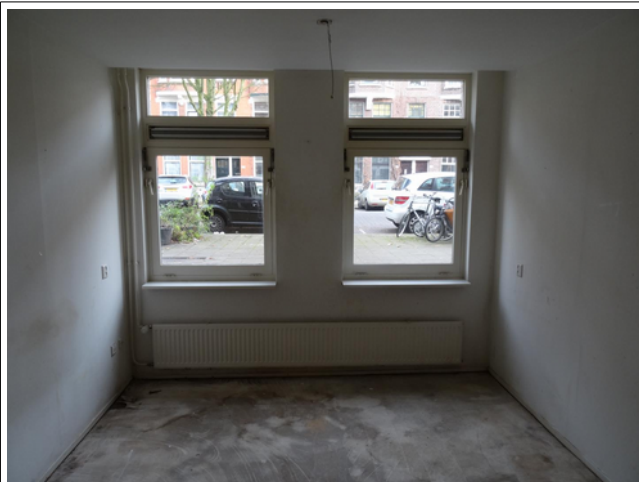
Foto 10: Raamkozijnen voorgevel souterrain/bg - hout
