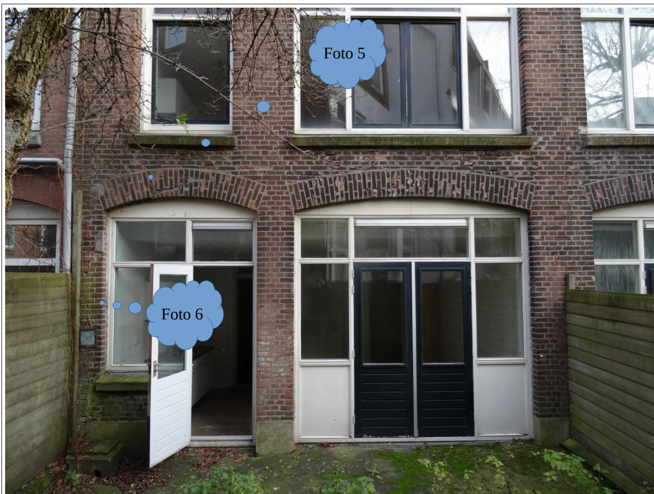
Foto 4: Overzicht achtergevel souterrain/begane grond
