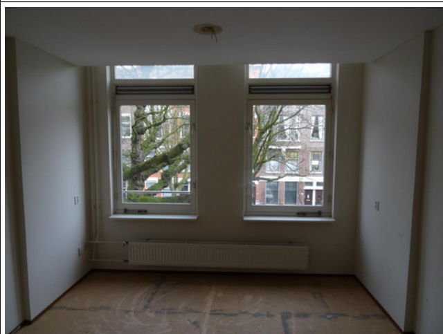
Foto 16: Raamkozijn voorgevel 2° verd - hout
