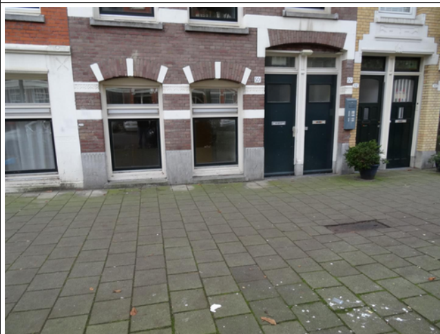
Foto 2: Overzicht voorgevel souterrain/begane grond
