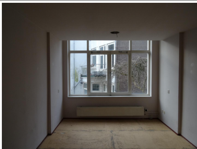
Foto 13: Raamkozijnen achtergevel 1° verd – hout
